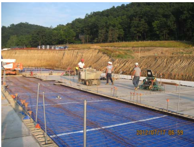
Concrete Slab Pour and Prep.
